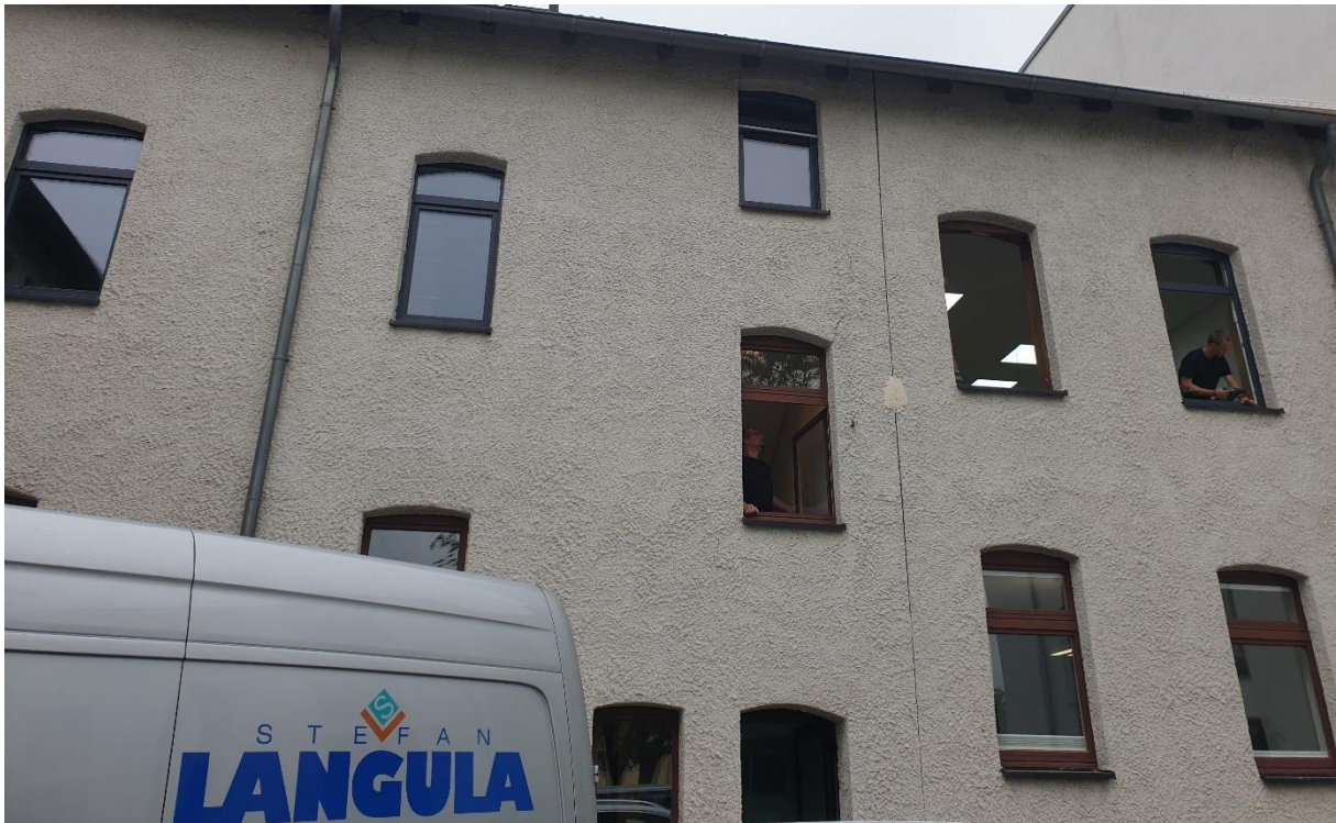
Austausch der Fenster im Rathaus Altbau 2024
