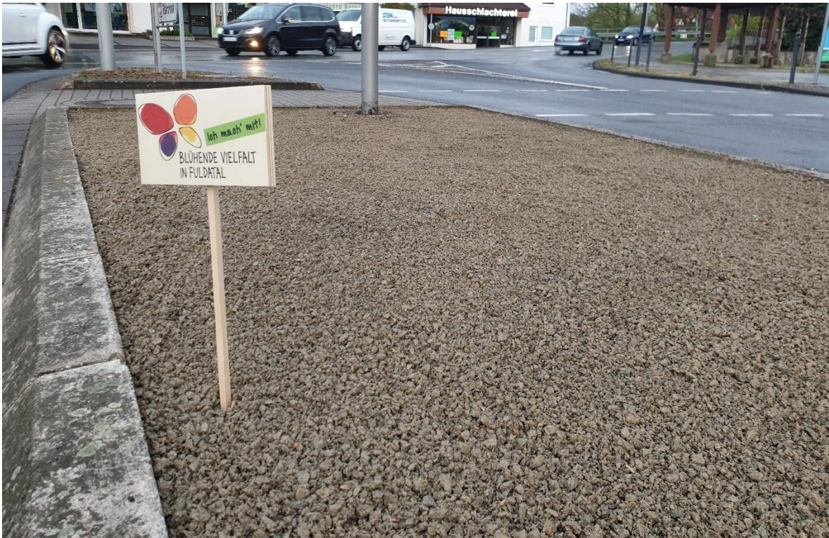
Bodenaustausch auf der Verkehrsinsel Niedervellmarsche Str./Veckerhagener Str. 2024
