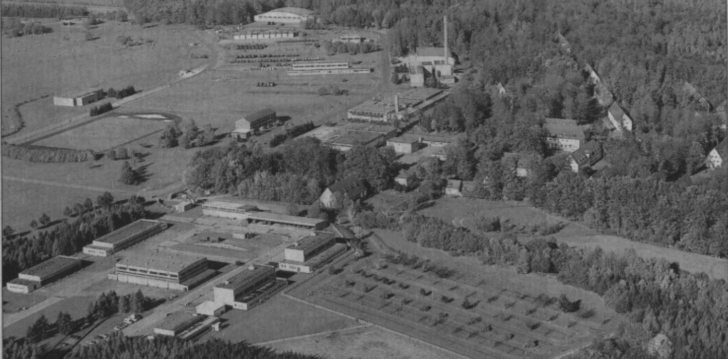
Weitläufig: Insgesamt umfasst das Gelände der Fritz-Erler-Kaserne in Rothwesten 160 Hektar. Es geht weit über den Bereich hinaus, der auf dem Luftbild von unserem Fotografen Jochen Herzog zu sehen ist. Links ist der Sportplatz zu erkennen.
