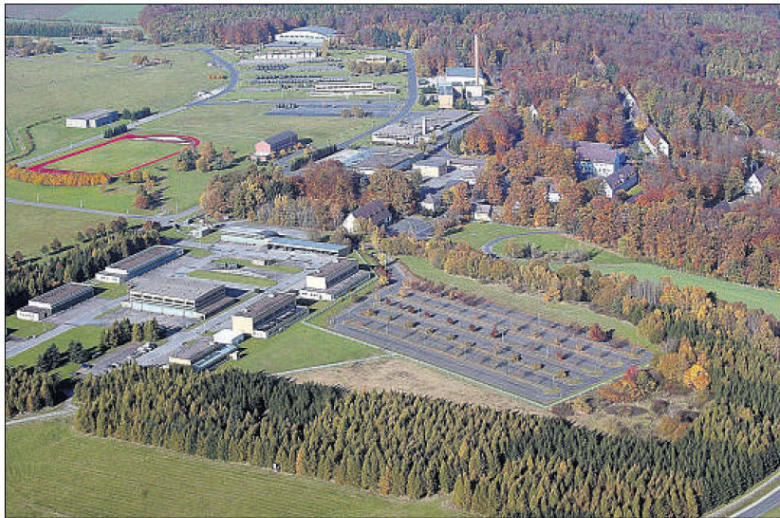
Viel Fläche für Gewerbe: Das Gelände der ehemaligen Fritz-Erler-Kaserne in Rothwesten. Zunächst soll nur der Bereich außerhalb des Waldes mit den technischen Gebäuden vermarktet werden.
