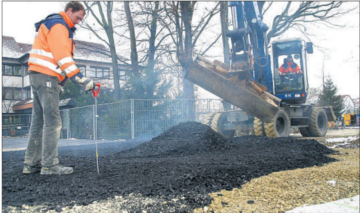
Schutzschichten: Um das Pflaster des Platzes zu sichern (im Hintergrund das Rathaus), werden ein Vlies, Kalksandstein und Asphalt aufgebracht. Baggerfahrer Stephan Eck verteilt den dampfenden Asphalt, Facharbeiter Johannes Hoffmann prüft die Stärke. Fotos: Schräer
