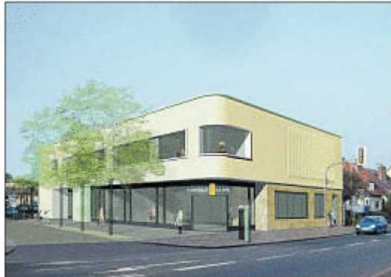
Beschlossene Sache: Der Bürgersaal schlägt mit 2,1 Millionen Euro zu Buche. Foto: Entwurf der Kasseler Arbeitsgemeinschaft foundation 5+ und Bankert + Linker
