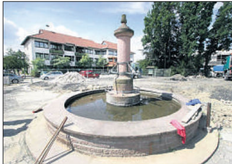
Schotterwüste: Abgefräst wird zurzeit auch die Abdeckung zum Schutz der alten Pflastersteinflächen rund um den Brunnen.
