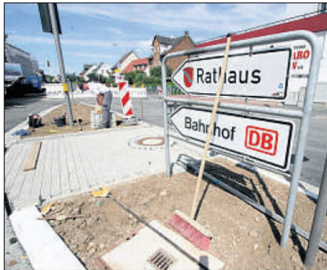
Neue Besen kehren gut: Letzte Arbeiten auch im Kreuzungsreich Niedervellmarsche/Veckerhagener Straße.
