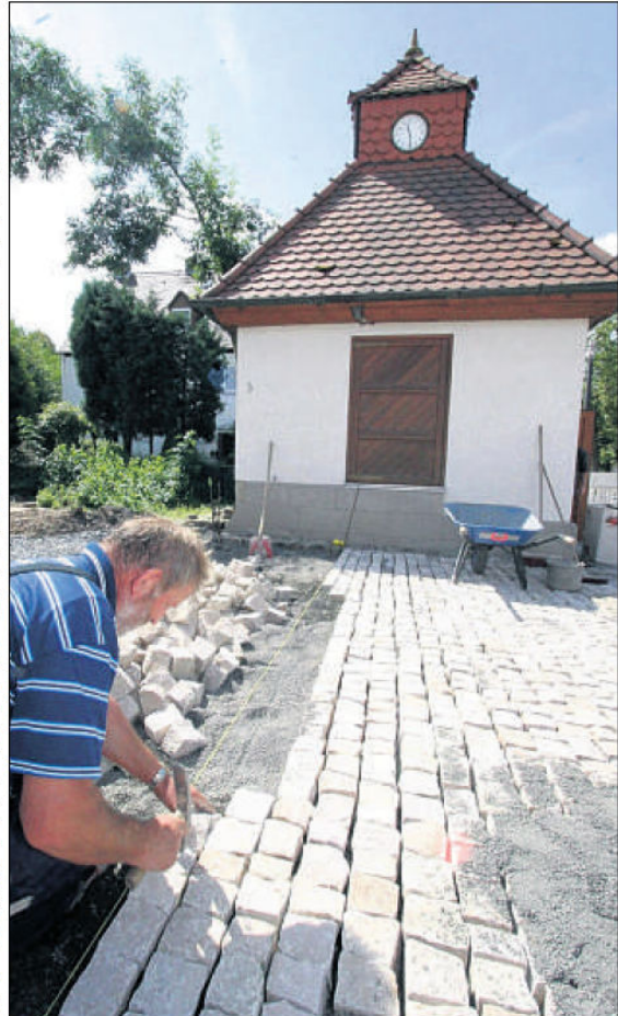
Schweißtreibende Arbeit: Zum Teil erneuert wird das marode Pflaster in diesen Tagen - hier vor dem Uhrenhäuschen am Rathausplatz.
